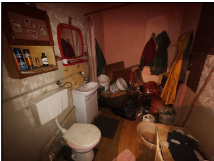
Zdjęcie nr 4 – widok na łazienkę.
